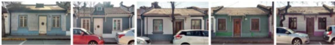
Figura 19 Fotos ZT Población Caja del Seguro Obrero. Fuente: Dirección de Barrios y Patrimonio.
